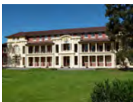
Keswick Barracks Building Works Keswick, SA
